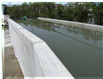
変位後の漏水なし
