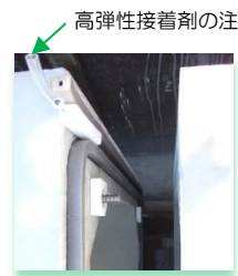
上面から下方を見る
