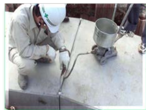
注入口より側壁部・底版部へ注入
