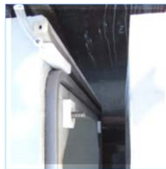
T Bジョイントバー挿入状況
