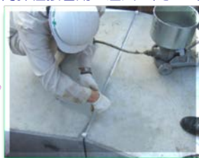
上部より頂版天端部へ注入
