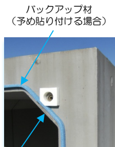
充填前 高弾性接着剤の充填部(内目地)
